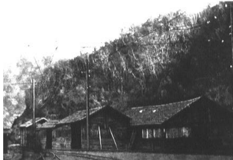
Atelier de réparation d'origine à Ibaraki (1910)
